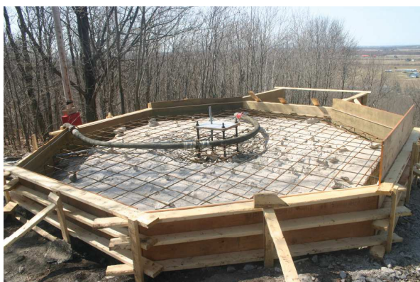
COFFRAGE DE LA BASE
