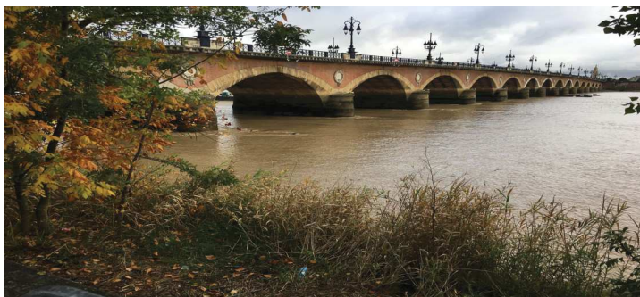
PONT DE PIERRE SUR LA GARONNE - CONSTRUIT SOUS NAPOLÉON
